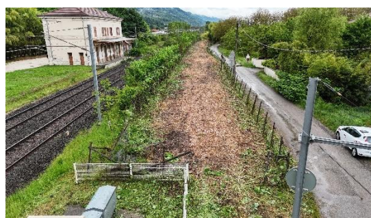
Figure 18 : placette broyée après le débroussaillage de finition
