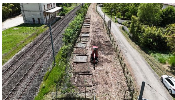
Figure 19 : fin des travaux d'installation de l'expérimentation
